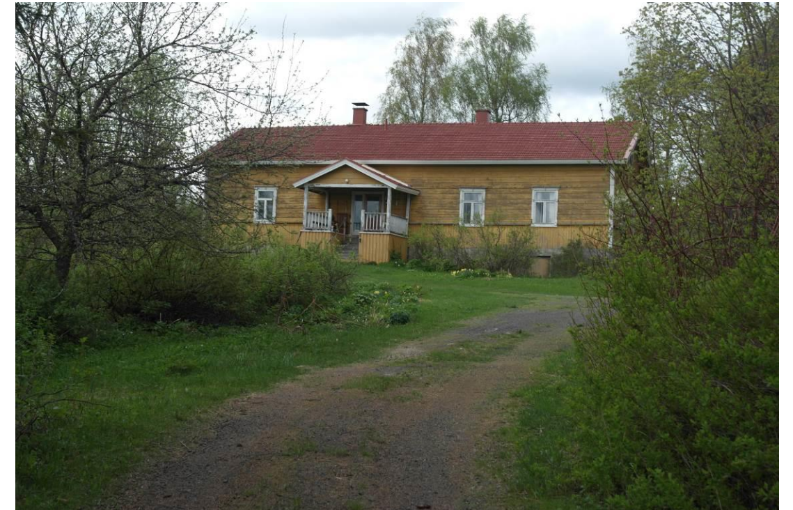
Jäniksen tilan päärakennus
