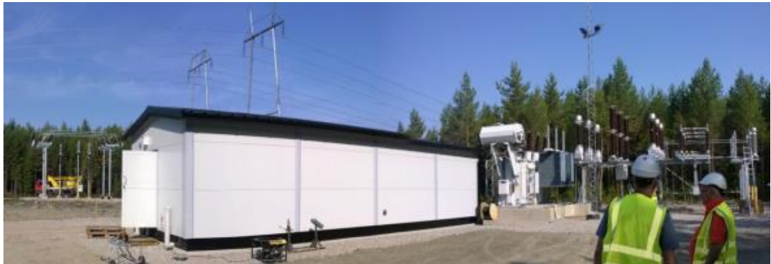
Kuva 26 Esimerkki rakenteilla olevasta tuulivoimapuiston sähköasemasta.
