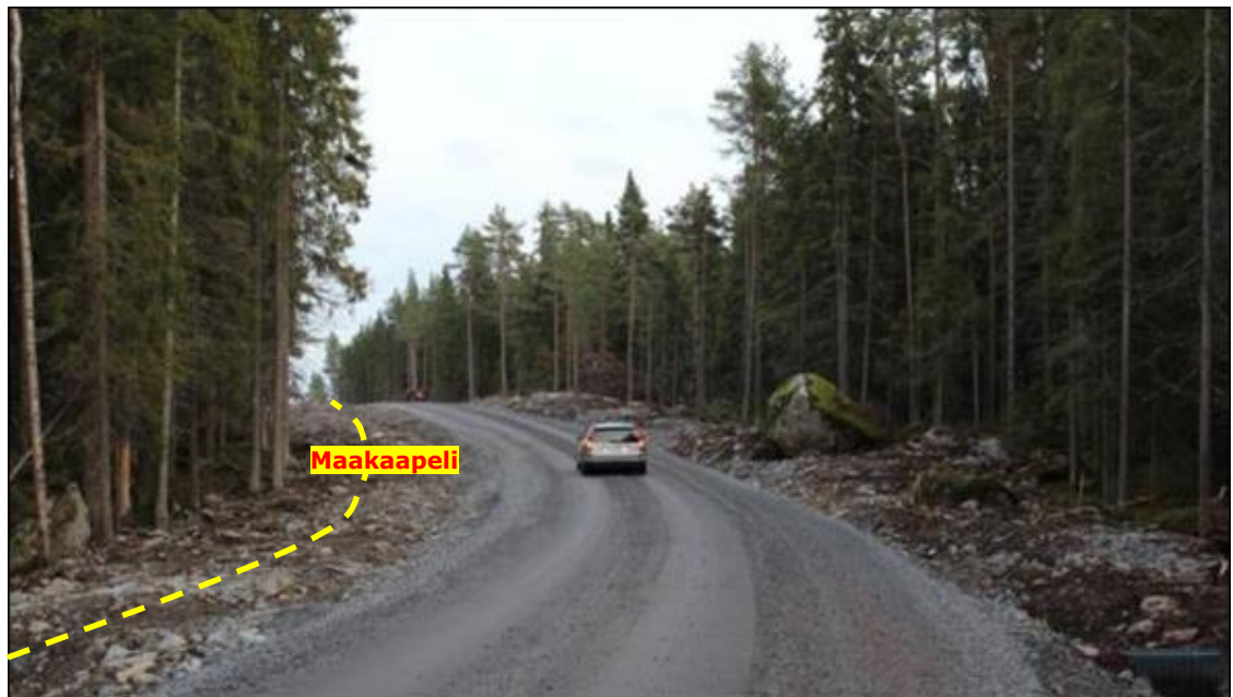
Kuva 24 Esimerkki tuulivoimapuiston rakennus- ja huoltotiestä. Teitä käytetään muun muassa betonin ja soran sekä voimaloiden komponenttien kuljetuksiin. Tuulivoimapuiston käyttövaiheessa teitä käytetään mm. vuosittaisessa huolloissa. Maakaapelin oja on sijoitettu tien vasemmalle puolelle.
