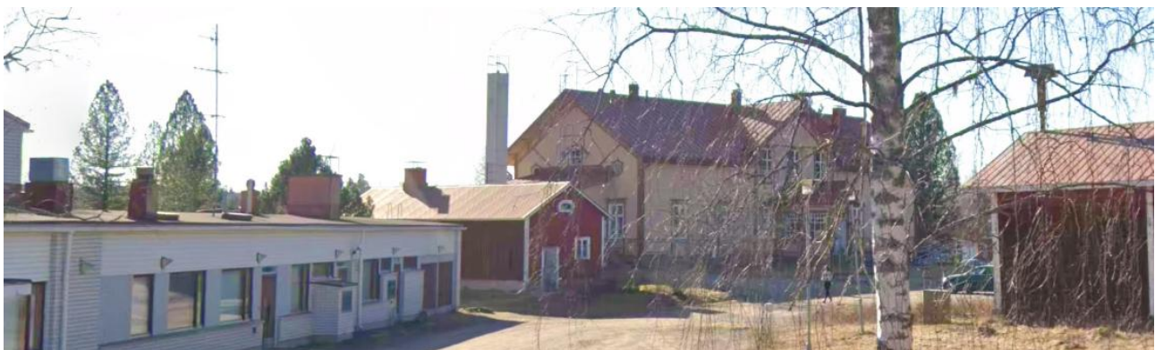
Kuva 12: Pappila Asematien suunnasta. Kuvassa etualalla vasemmalla seurakuntatalon takajulkisivu.
