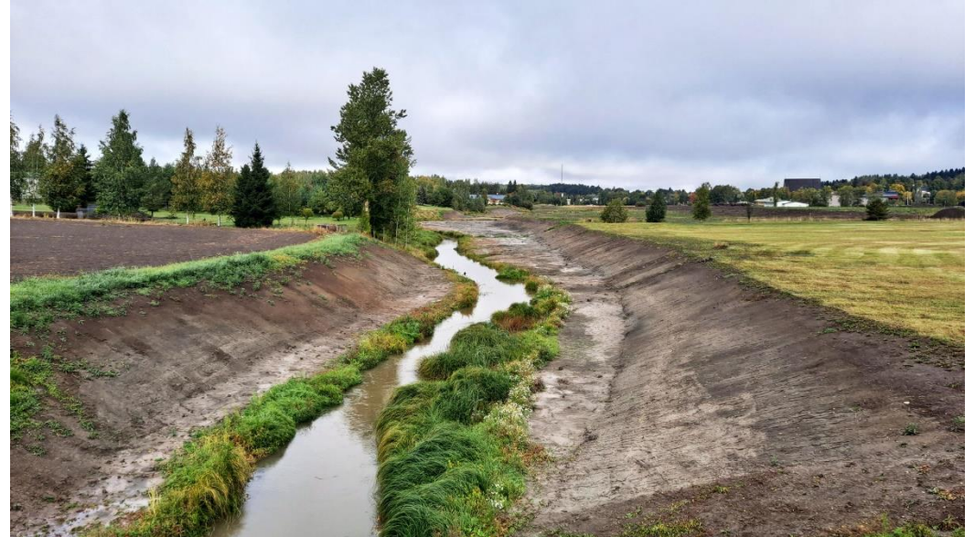
Rakennettu kaksitasouoma Perniönjoessa Varsinais-Suomessa. (Kuva: Janne Tolonen)
