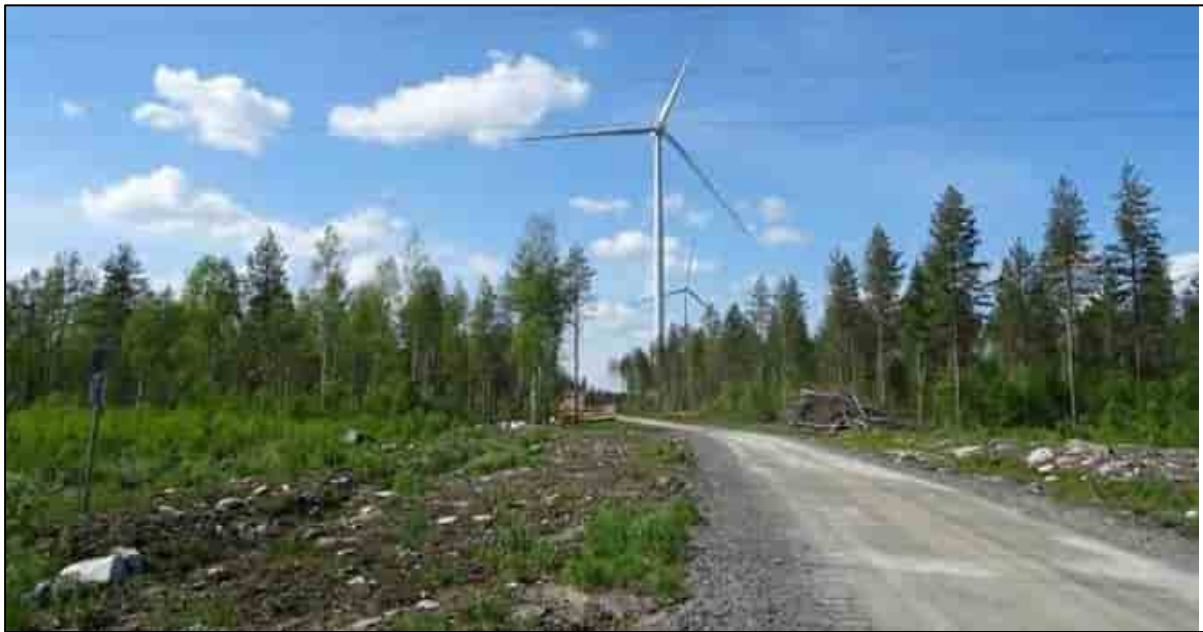
Kuva 46. Esimerkki tuulivoimapuiston rakennus- ja huoltotiestä. Teitä käytetään muun muassa betonin ja soran sekä voimaloiden komponenttien kuljetuksiin. Tuulivoimapuiston käyttövaiheessa teitä käytetään mm. vuosittaisissa huolloissa. Maakaapelioja on sijoitettu kuvassa tien vasemmalle puolelle.
